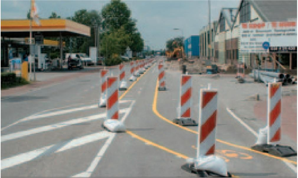
libre de al menos 0,60 m; como las obras se están llevando a cabo cerca de la cicloruta, esto probablemente permitirá mantener una distancia suficiente de los obstáculos. Se debe mantener una franja de seguridad de por lo menos 5 m entre las obras y la barrera de contención/ vehículo con señalética de desvío
