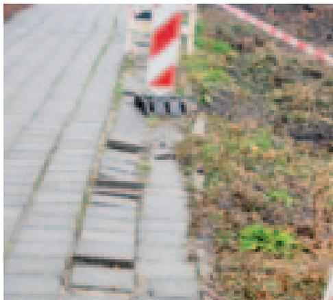
Donde las subrasantes tienen una capacidad de carga muy limitada, sólo se considera el uso de losas (incluso como fundaciones) cuando se sabe con seguridad que no se tendrá que soportar cargas pesadas. Se puede ir mejorando continuamente los pavimentos de superficie cerrada (asfalto y hormigón), para reforzar la capacidad de carga de la subrasante.
